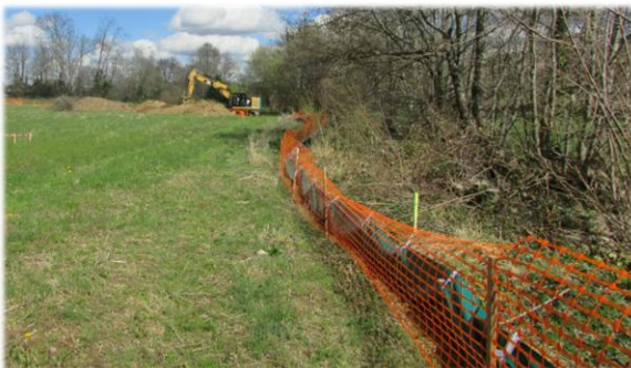
Pose d'un filet anti-retour
