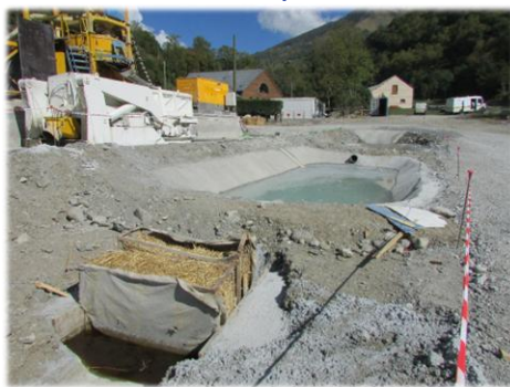
Mise en place d'un filtre à paille
